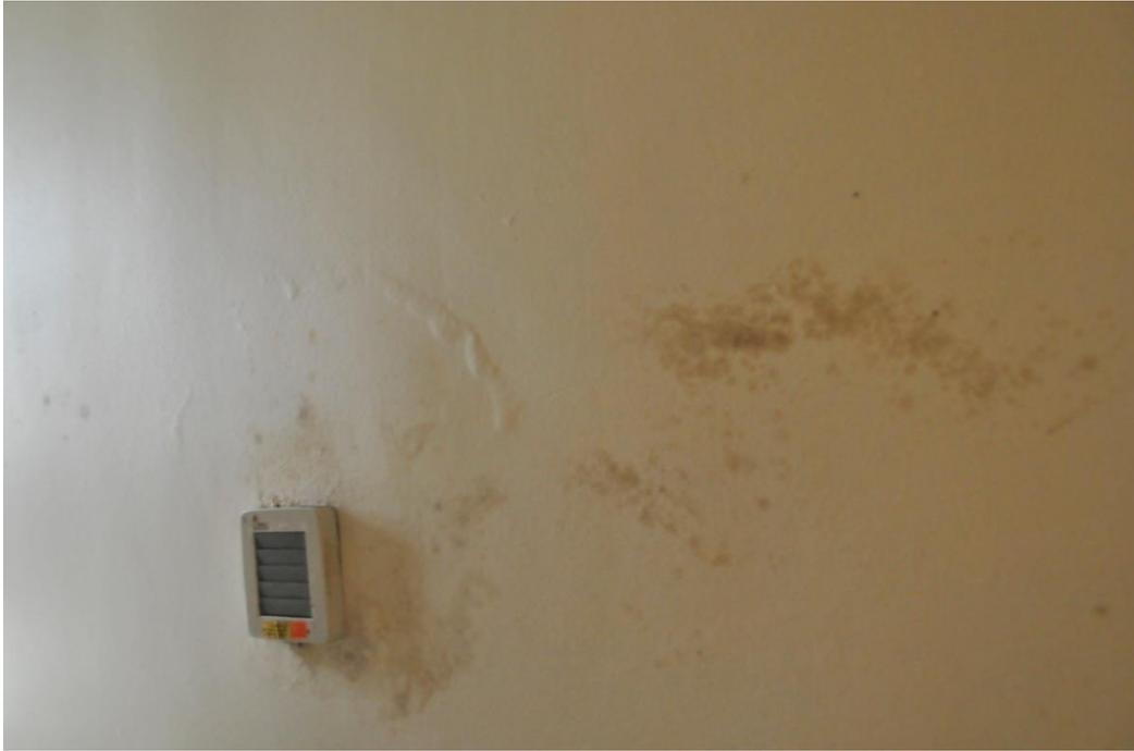
Bild 1: Stockflecken unter der Geschossdecke Sanitärbereich
